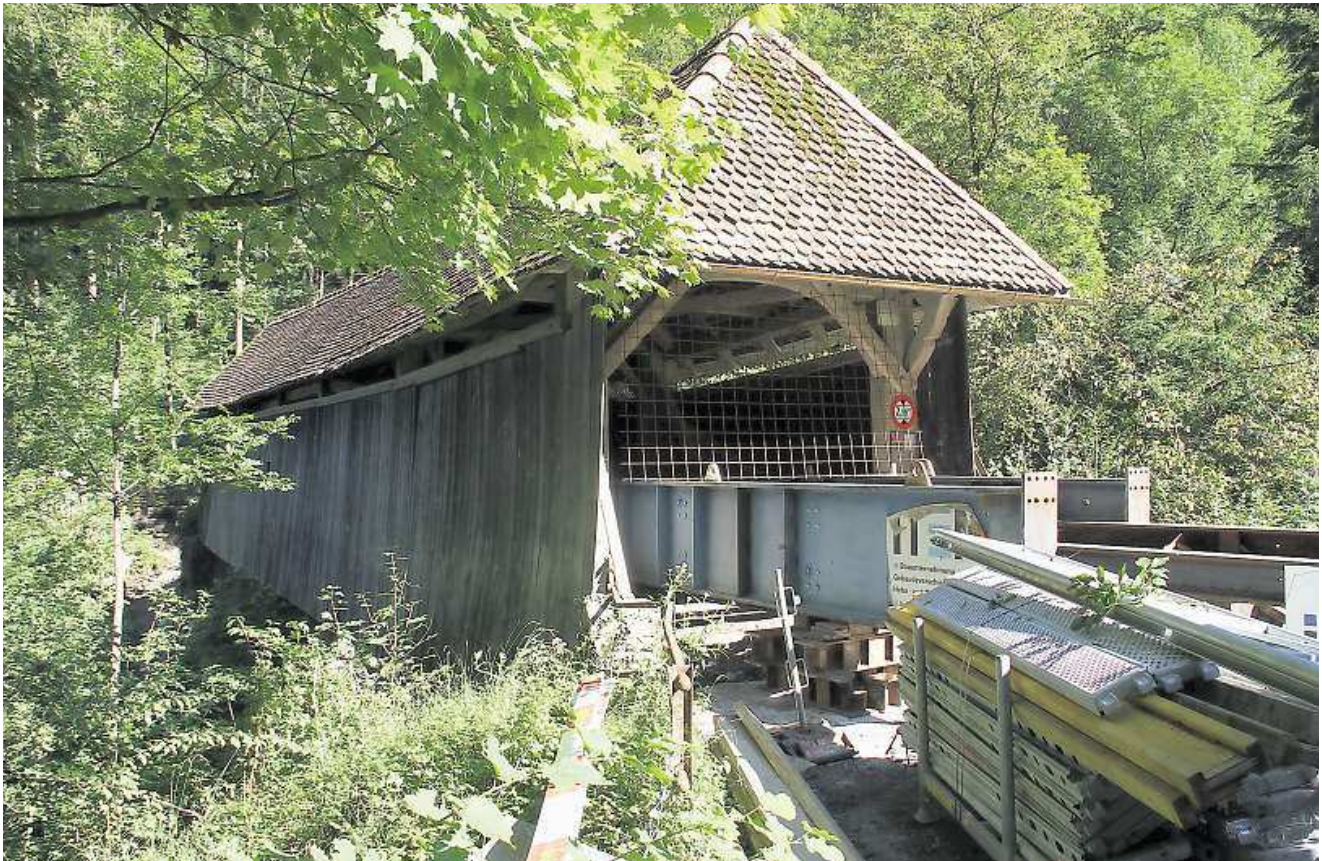
Sperrig: Mit «grobem Gerät» haben die Sanierungsarbeiten an der Suworowbrücke begonnen.
