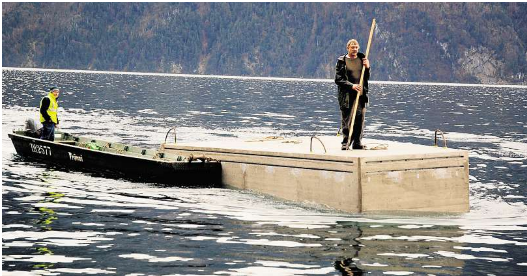
Das Ziel erreicht: Eines der beiden Betonelemente wird in den Hafen Felsenegg eingefahren.
